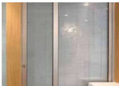
Dettaglio della parete manovrabile insonorizzata in vetro con tenda veneziana inserita Detail of the movable sound-insulated glass partition with Venetian blind inserted
